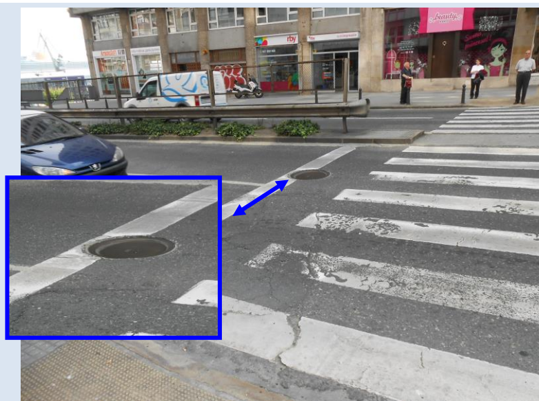
Tapa de arqueta. R/Ramón de la Sagra, salida de la ciudad. Es apreciable el ruido de los vehículos por no encontrarse al nivel de la superficie de rodadura.
