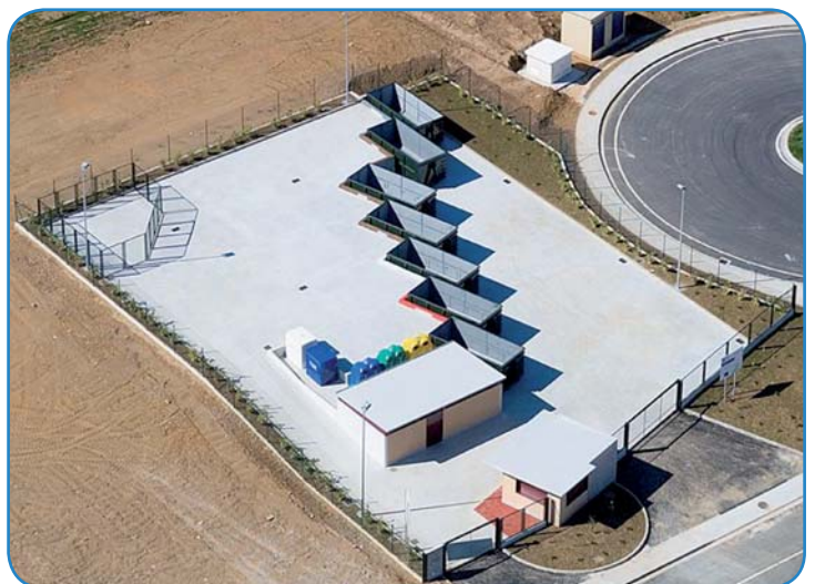
Fotografía aérea dunha instalación tipo de punto limpo, construído pola CMATI.
