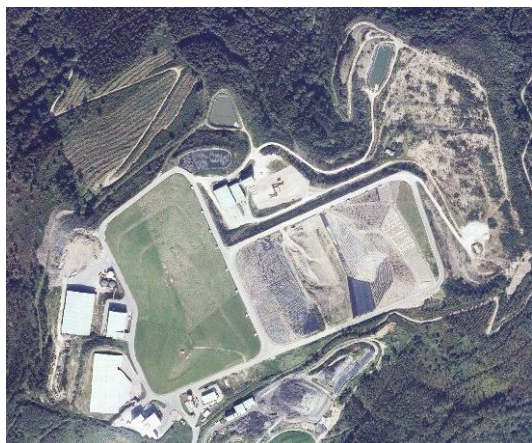
Figura 3.- Vista aérea de la zona II del CTRIG
